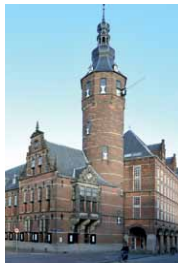
Kantoor Provincie Groningen
